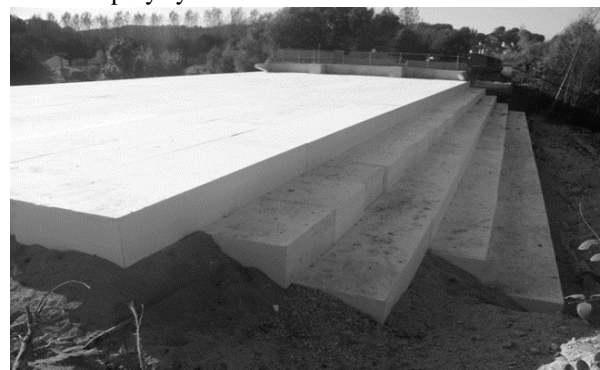
Fig. 2.Example or type KNAUF TP 120 EPS blocks in an embankment
